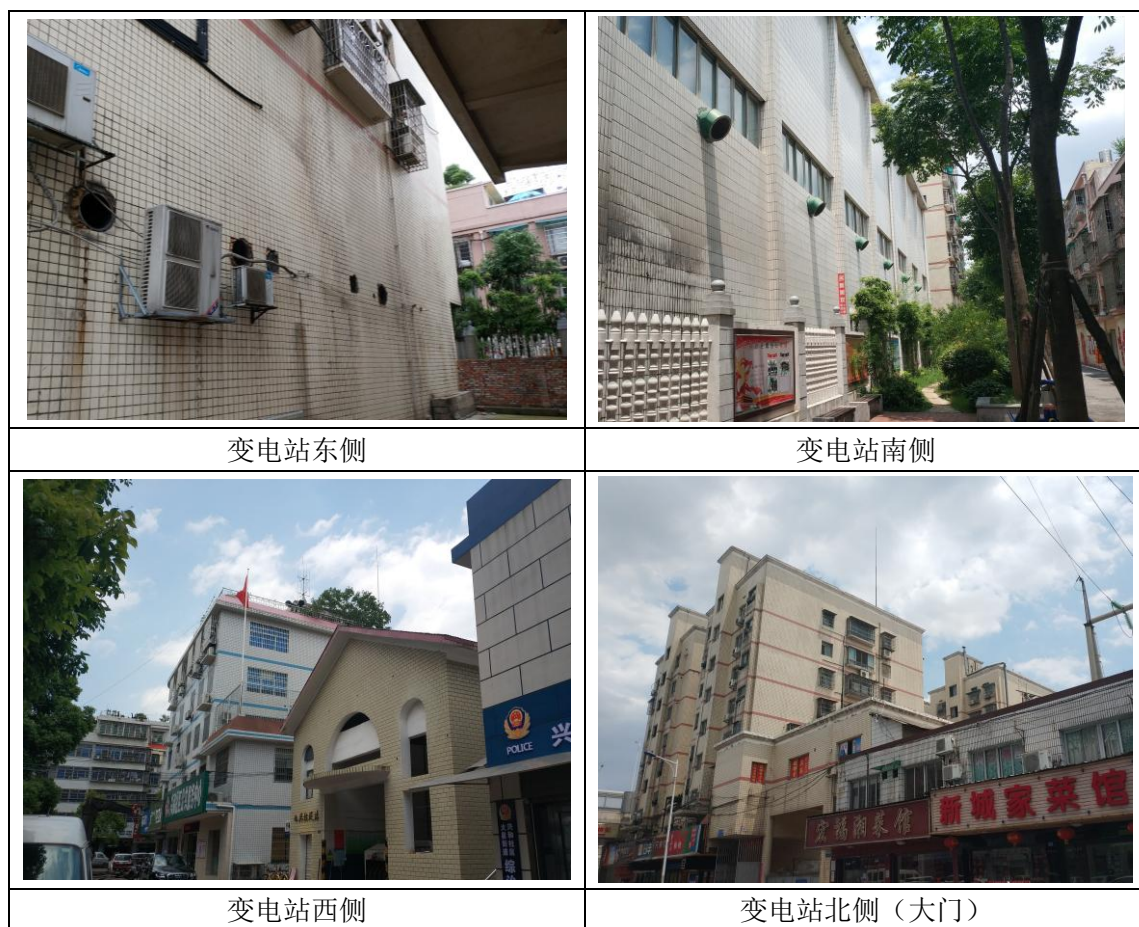
图 2-1 马王堆 110kV 变电站周边环境
