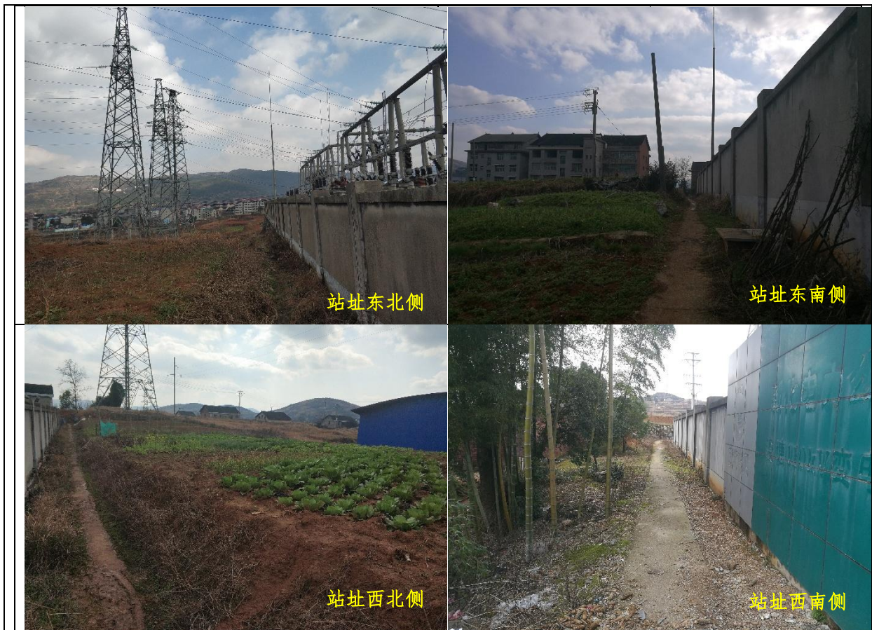
温塘 110kV 变电站站址四周
