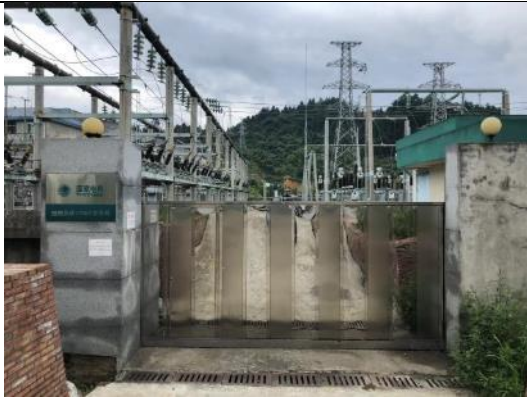
关峡 110kV 变电站大门
