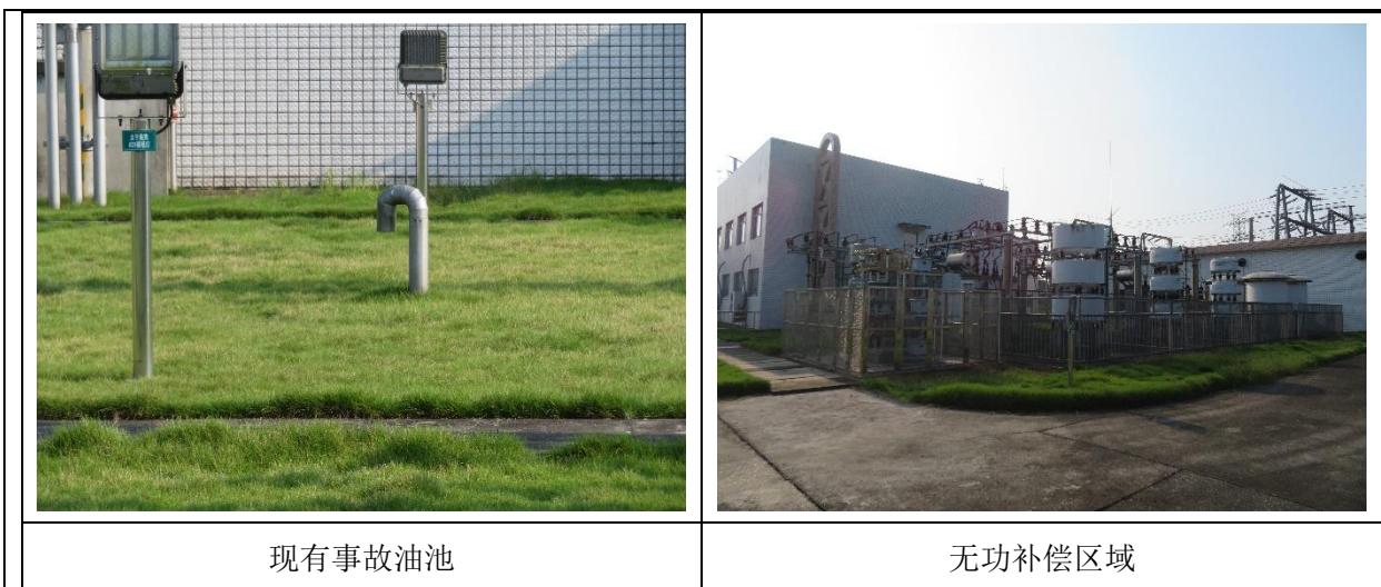
图 3 太子庙 220kV 变电站现有情况
