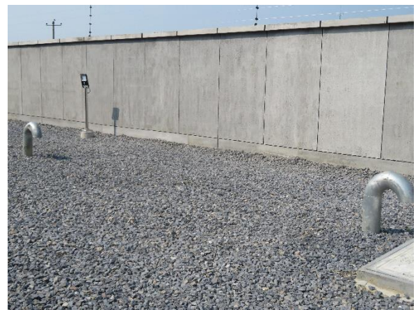
现有事故油池
