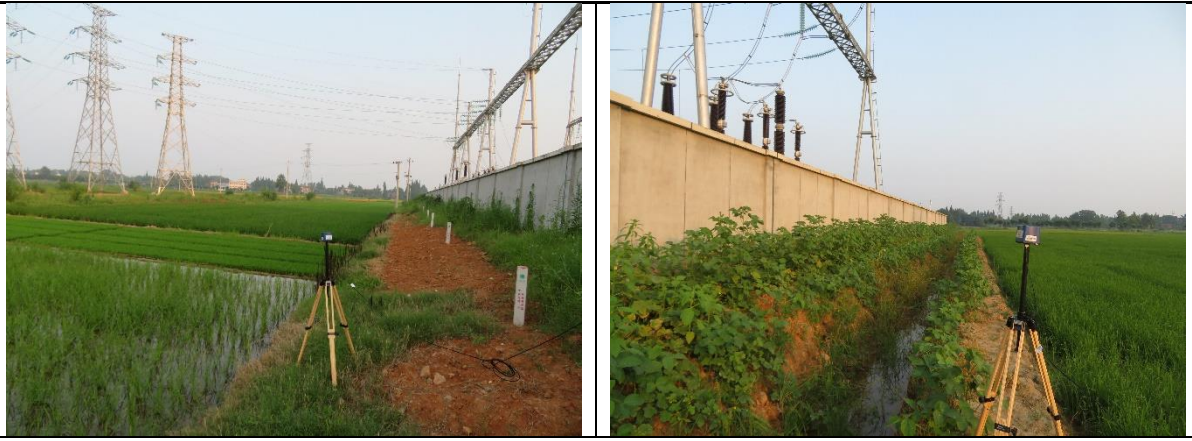
同心 220kV 变电站站区环境现状
